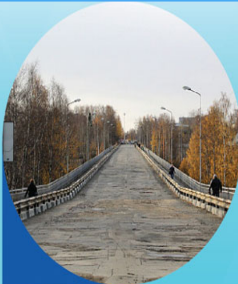
– ремонт Гоголевского моста в Петрозаводске
