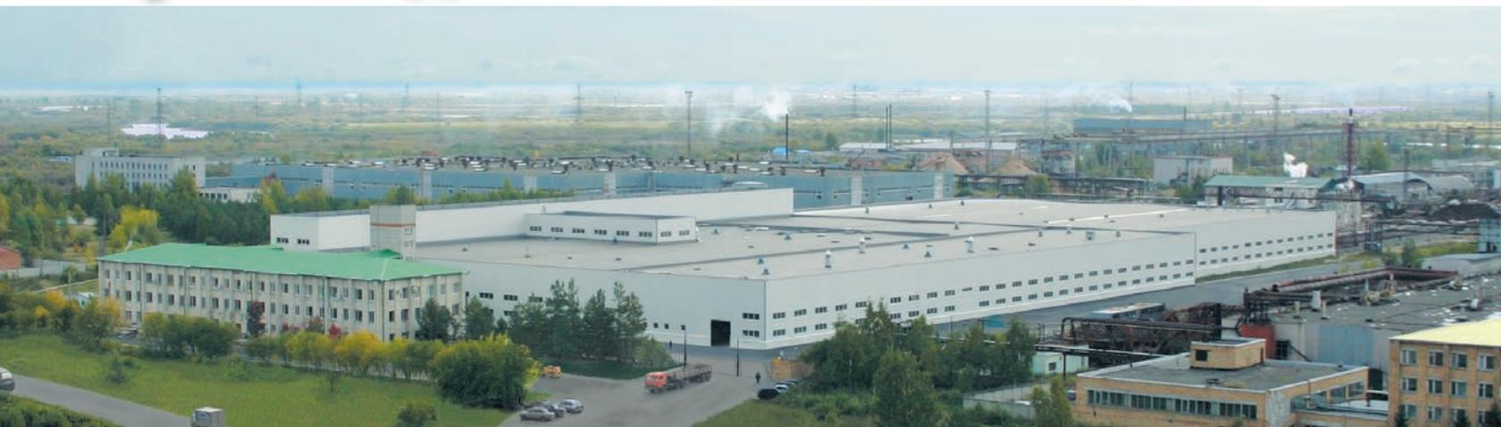
Благодаря многолетнему труду всего коллектива Тюменского фанерного комбината, построен и запущен в эксплуатацию новый завод по производству фанеры, соответствующей Европейским форматам: 2500x1250мм и 1250x2500мм. В настоящее время полностью смонтирована первая высокотехнологичная линия производства фанеры с проектной мощностью выпуска продукции в объёме 30 тыс. м<sup>3</sup>/год.
