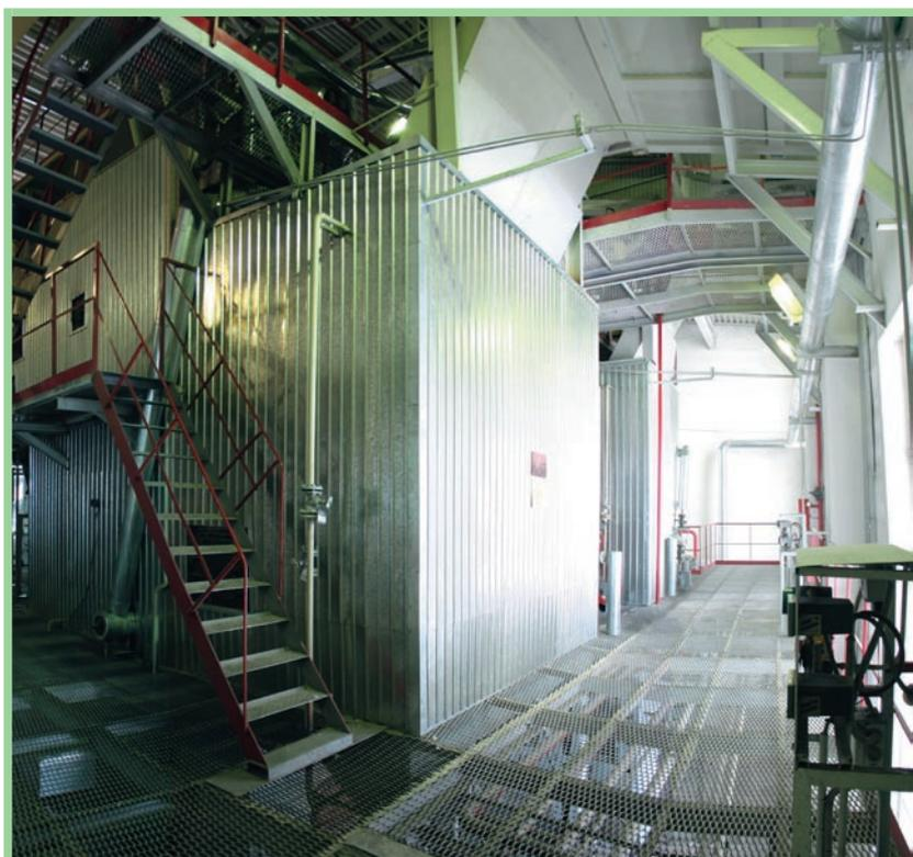
Паровая котельная с мощностью 1-ой очереди — 11,5 ГКал, работающая на биотопливе. Контроль и управление энергетическим хозяйством осуществляется с дистанционного пульта управления.
